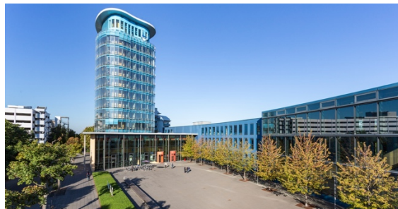
Bild 2: Die SRH Hochschule Heidelberg: Eine Campushochschule im SRH-Verbund auf 100.000 m 2 mit Wohnheimen, Bibliothek, Mensa, Campus Sports sowie dem markanten und modernen Science Tower
